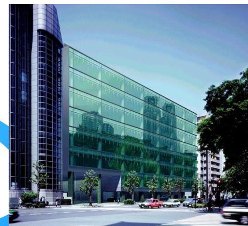
都市型データセンター
