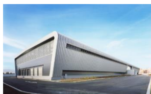
石狩 データセンター
