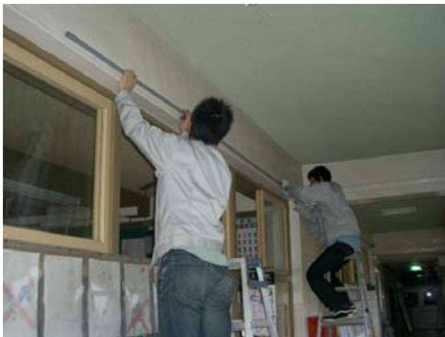
ケーブルの管路を作っている
