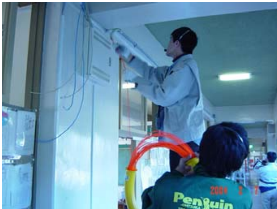
ケーブルを通線中
