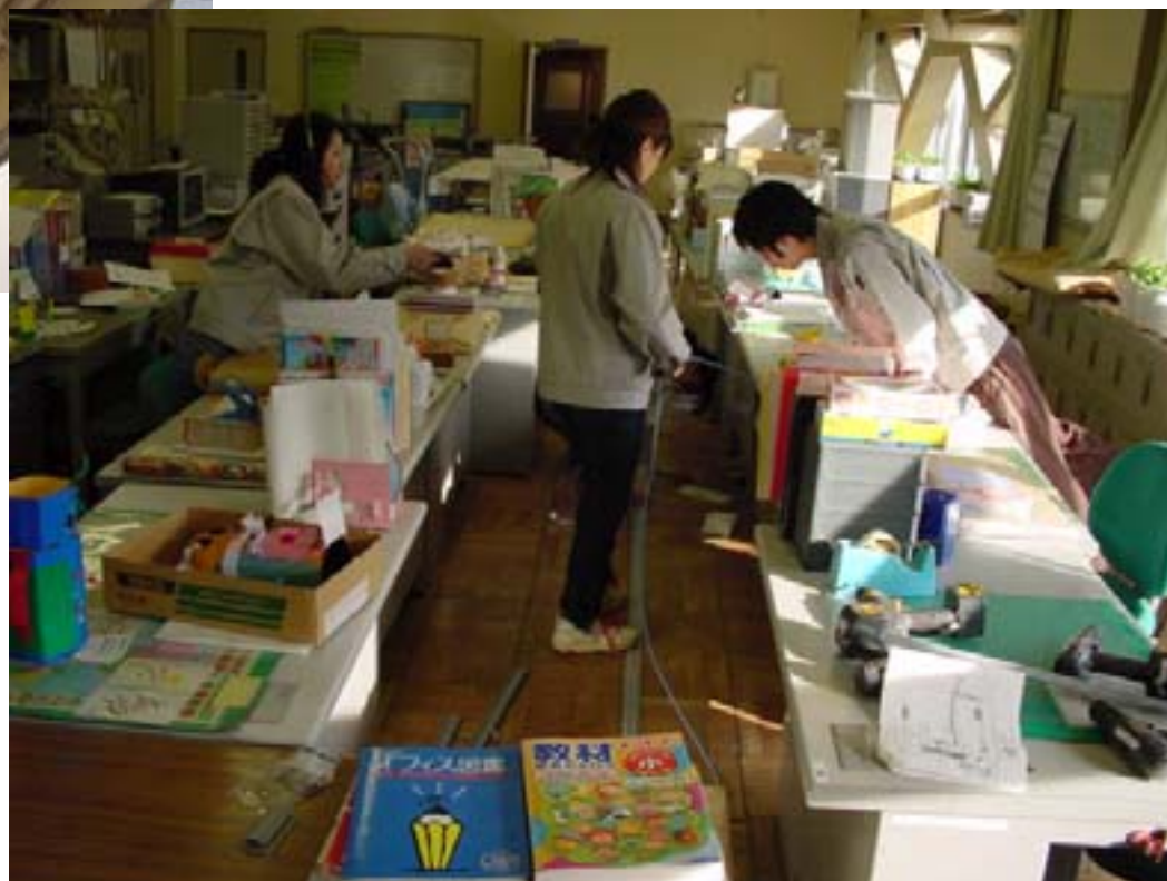
職員室の配線工事
