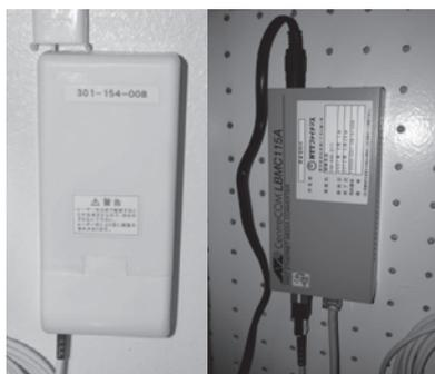
図2 各部屋の光パッチパネル（左）とメディアコンバータ（右）
